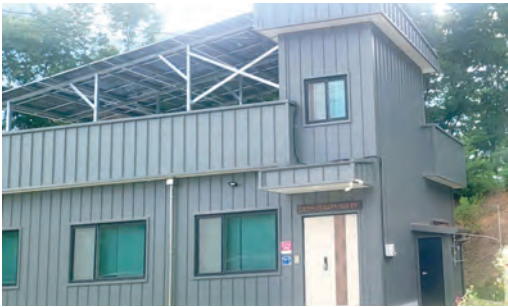
안동권씨문중 검교공파 서천공종회관. 권정수 회장이 실용성 높게 현대식 건물로 건립하여 문사를 위해 사용하도록 할 예정이다.
